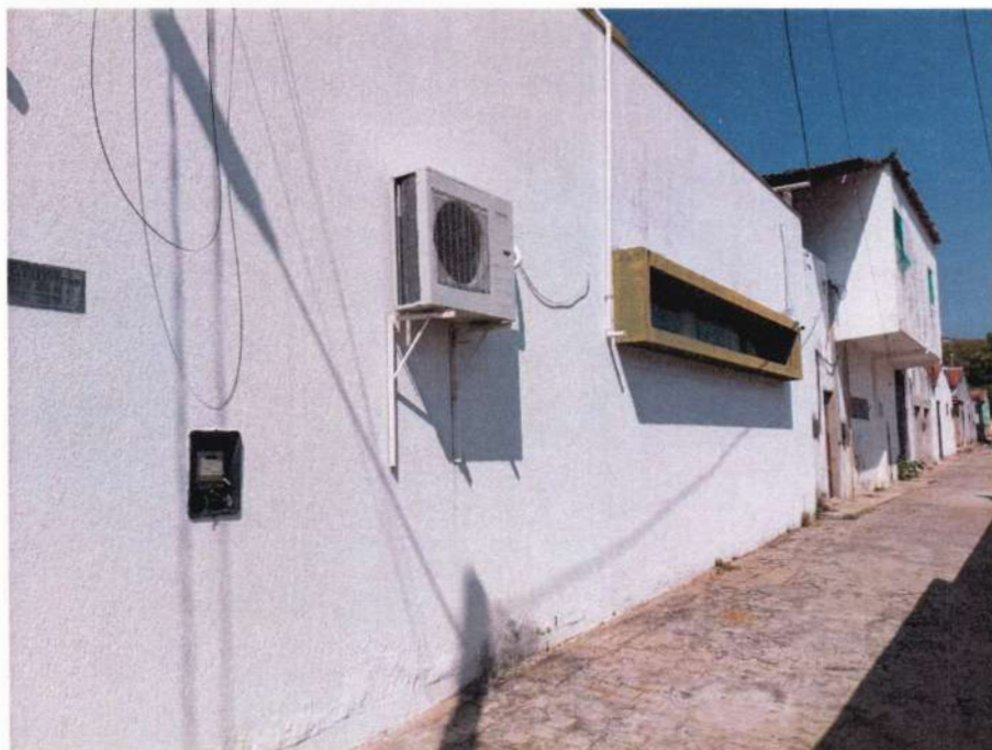
Foto 09: Detalhe do destacamento da textura e da caixa de medidor sem a tampa;
