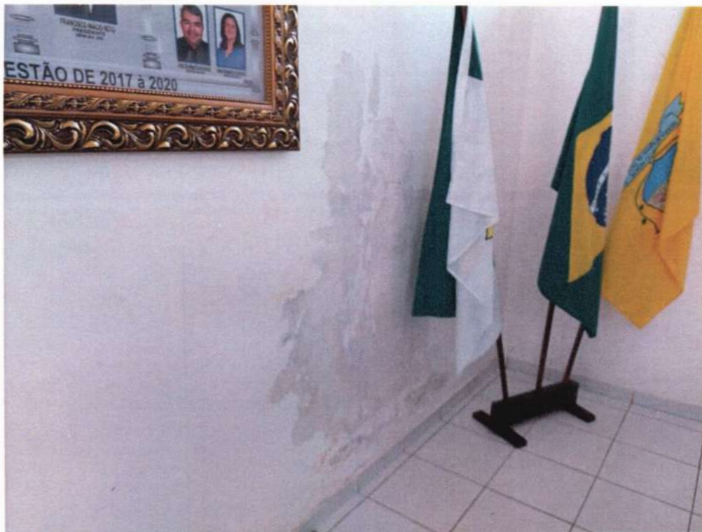
Foto 03: Detalhe da umidade na parede;
