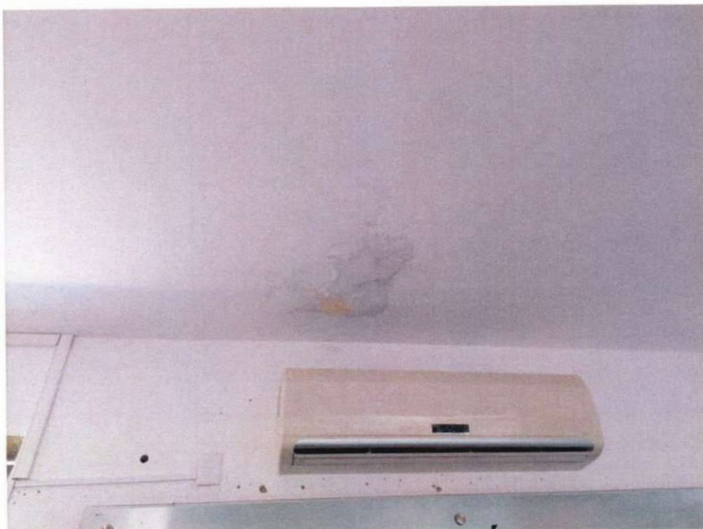
Foto 04: Detalhe da umidade no teto;
