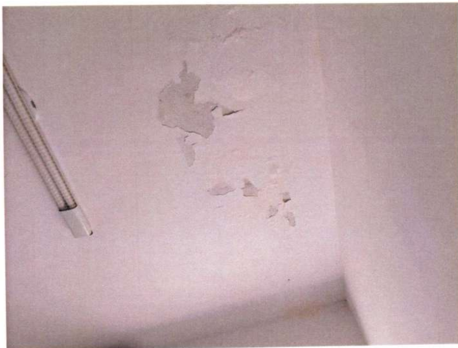
Foto 05: Detalhe da umidade no teto;
