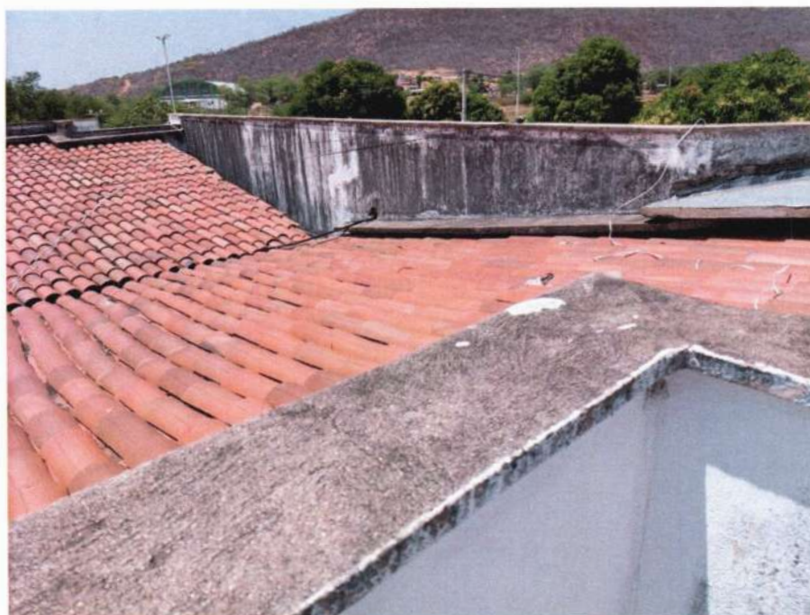
Foto 15: Detalhe da calha a ser impermeabilizada;
